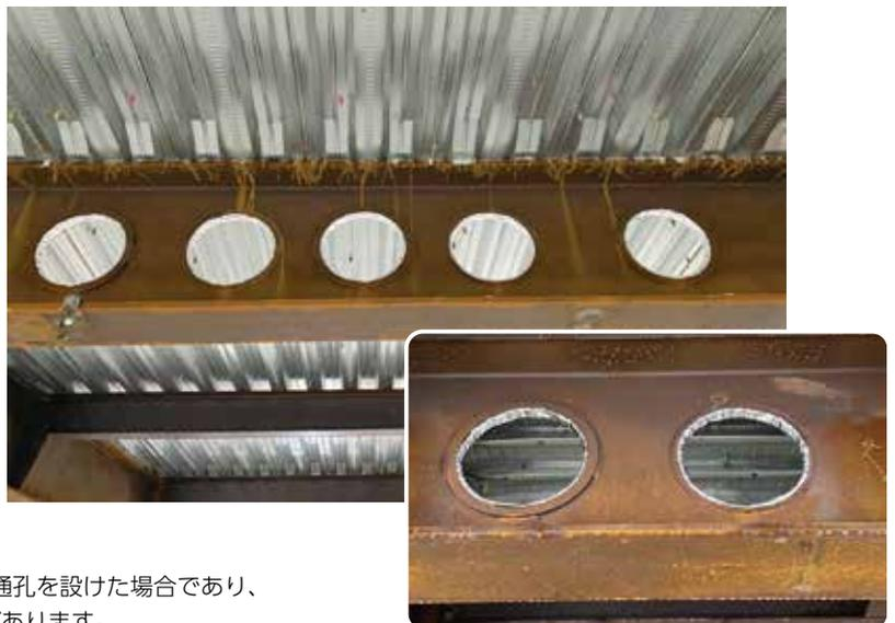
●本ページ (P14,15) はハイリング併用で最大2/3の貫通孔を設けた場合であり、耐力検討により最大2/3の貫通孔を設けられない場合があります。
